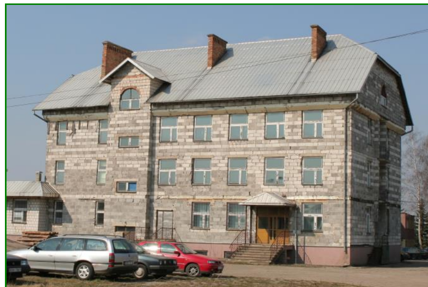
Budynek socjalny — budynek nowy, wewnątrz ukończony parter i piwnica
